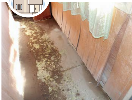
河川の氾濫により、床上が浸水。壁や床に汚損が発生しました。
