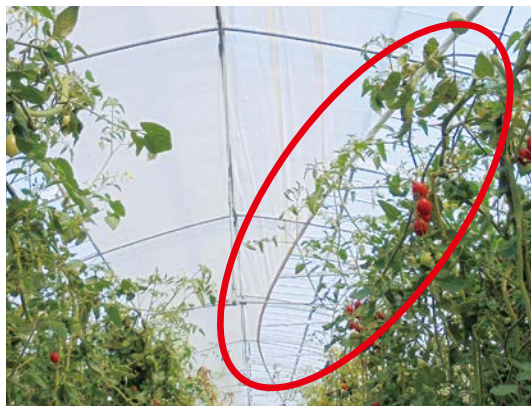
風でビニールがめくれ二重カーテンに被害が発生した（付帯施設加入での補償対象）
