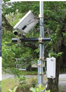
公民館に 設置してある アンテナ
