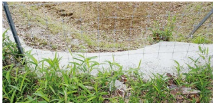
地面を舗装し、柵の下側をコンクリートで覆っている
