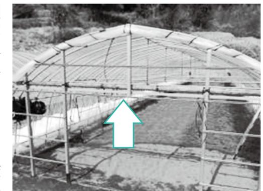
写真2 丸太による横梁の補強
