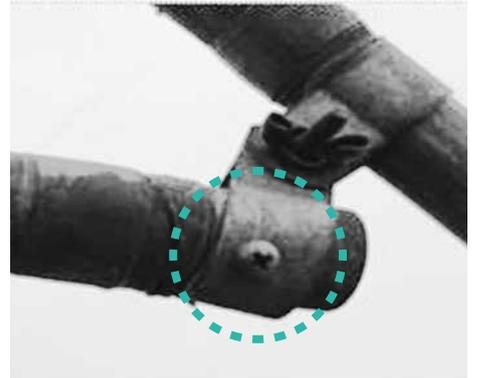
写真3 ボルトによる丸太の固定
