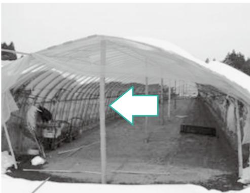
写真1 竹支柱による補強
